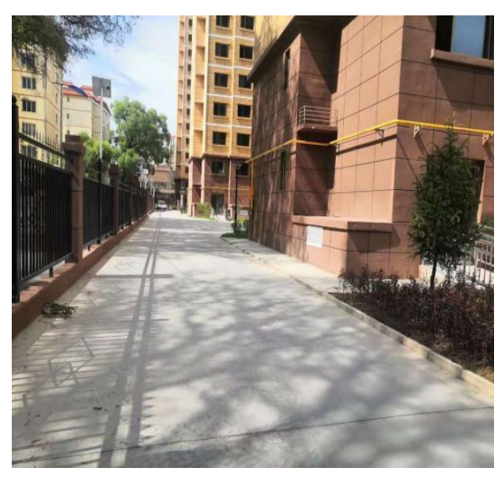
地下车库排风口
